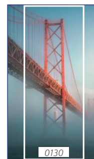
Pont du 25 avril
