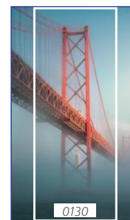
Pont du 25 avril
